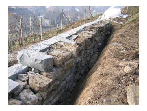
Die Mauer wird mit Neigung (Anzug ca. 10-15%) gegen den Hang aufgeschichtet, wobei die Steine im Verband und mit möglichst engen Stoss- und Lagerfugen vermauert werden. Etwa ein bis zwei lange Steine - Bindersteine - werden je Quadratmeter durchbindend bis in das hinterfüllte Material eingebaut. Wackelnde Steine in der Sichtfläche der Mauer werden solange bearbeitet, bis sie passen. Im Hinterbau (Schroppen) könen diese mit Bruchstücken verkeilt werden.
