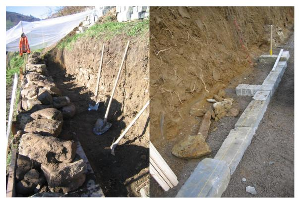
Normalerweise wird für das Fundament der Boden ca. 30-60 cm tief ausgehoben. Die Breite beträgt ca. 10-20 cm mehr als die effektive Mauerbreite. Als Faustregel gilt, dass eine Trockenmauer am Fuß in der Breite etwa mit einem Drittel der Mauerhöhe angelegt wird. Nimmt man als Beispiel die Mauerhöhe mit 120 cm an, so wäre der Fuß rund 40-45 cm breit. Die Breite von 45 cm sollte bei Mauern mit Stützfunktion nie unterschritten werden (auch wenn die Mauer weniger wie 120 cm hoch ist).
